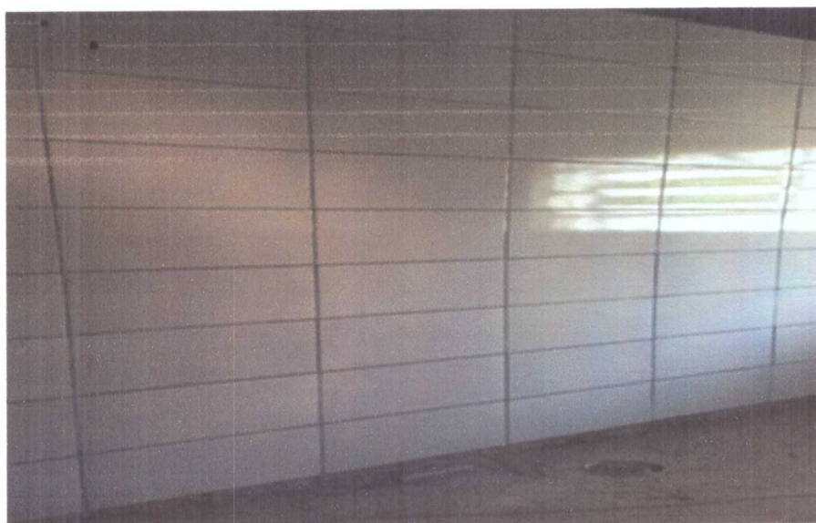
ASSENTAMENTO DE REVESTIMENTO DO PAREDE
