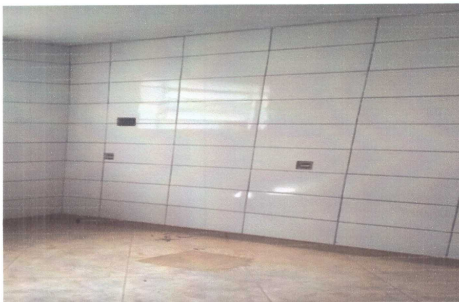
ASSENTAMENTO DE REVESTIMENTO DO PAREDE
