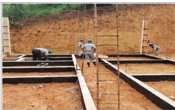
IMPERMEABILIZAÇÃO DA VIGA BALDRAME
