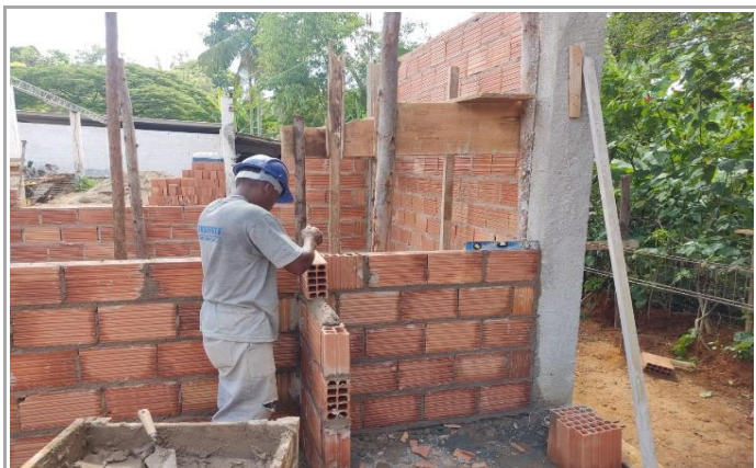
ASSENTAMENTO DE TIJOLO CERÂMICO
