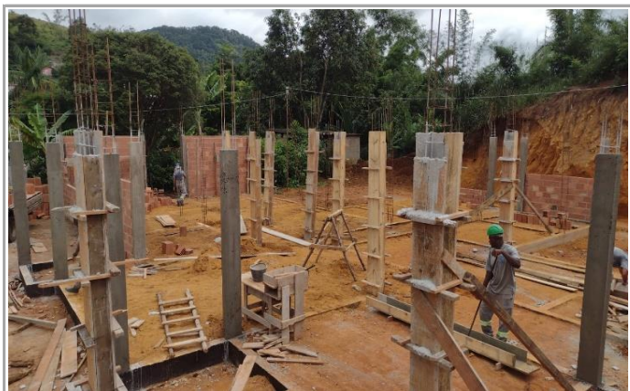
RETIRANDO FORMA DOS PILARES
