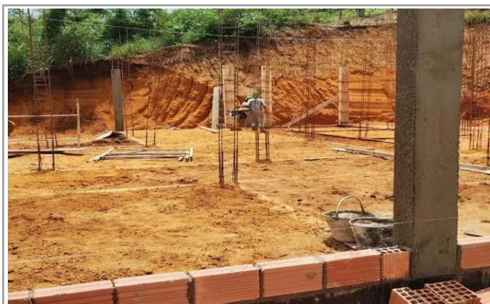
ATERRO DA VIGA BALDRAME
