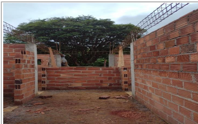
FERRAGEM DAS VIGAS DE CINTAMENTO
