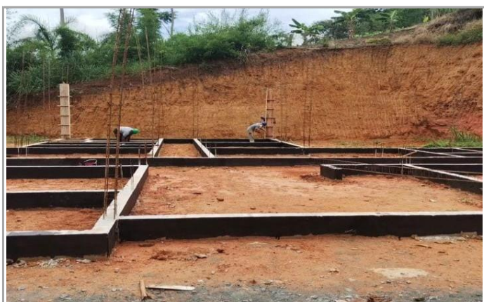
IMPERMEABILIZAÇÃO DA VIGA BALDRAME
