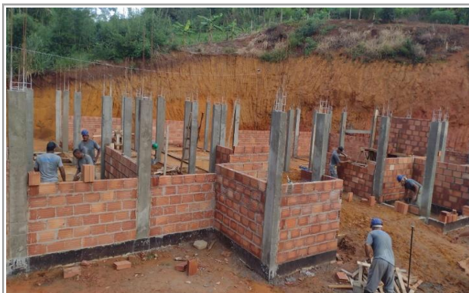
ASSENTAMENTO DE TIJOLO CERÂMICO
