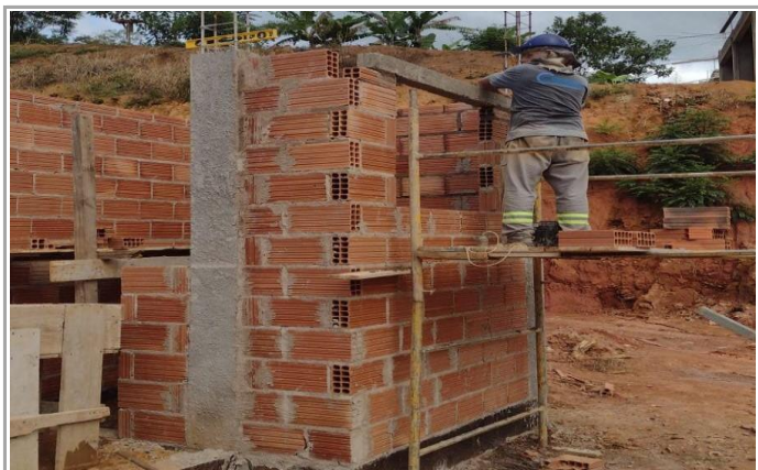
ASSENTAMENTO DAS VERGAS
