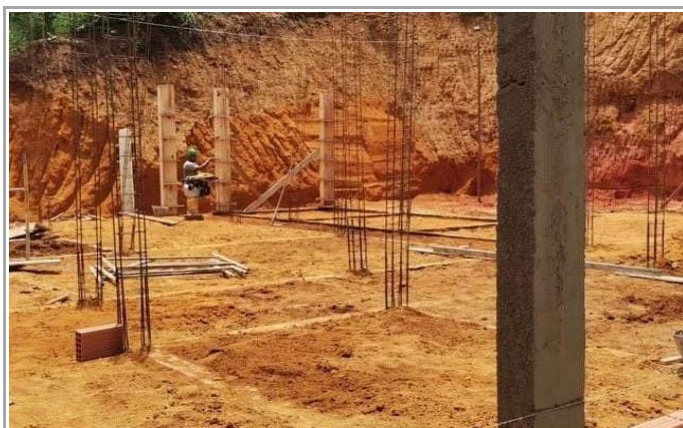
ATERRO DA VIGA BALDRAME
